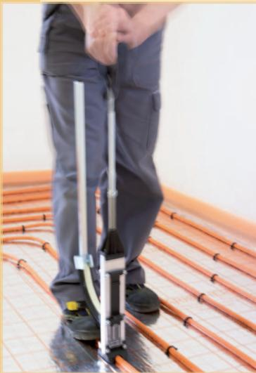
(1) VarioProFil-Rohr 16x2/Alu0,25 (Mehrschichtverbundrohr).
