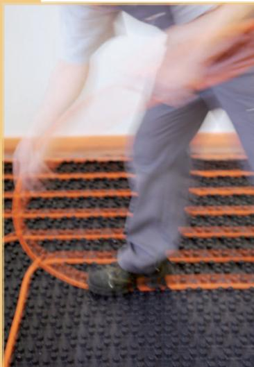
[1] VarioProFil-Rohr 16x2/Alu0,25 (Mehrschichtverbundrohr).
