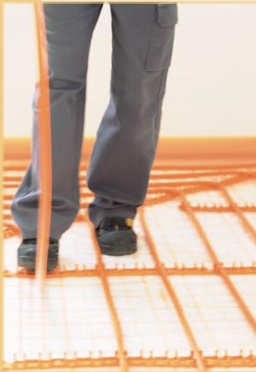
[1] VarioProFil-Rohr 16x2/Alu0,25 (Mehrschichtverbundrohr).
