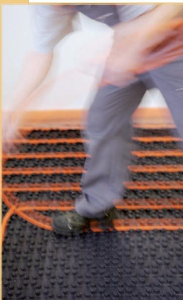
(1) VarioProFil-Rohr 16x2/Alu0,25 (Mehrschichtverbundrohr).
