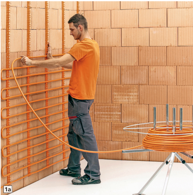
1a+b Ob als Nass- oder Trockenbauvariante: eine Wandheizung kann vor allem beim Thema „Thermische Behaglichkeit“ ihre Stärken ausspielen. (Fotos: Variotherm)
