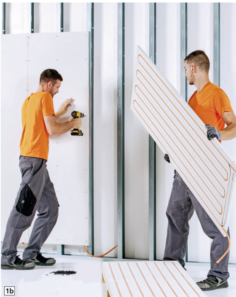
1a+b Ob als Nass- oder Trockenbauvariante: eine Wandheizung kann vor allem beim Thema „Thermische Behaglichkeit“ ihre Stärken ausspielen. (Fotos: Variotherm)
