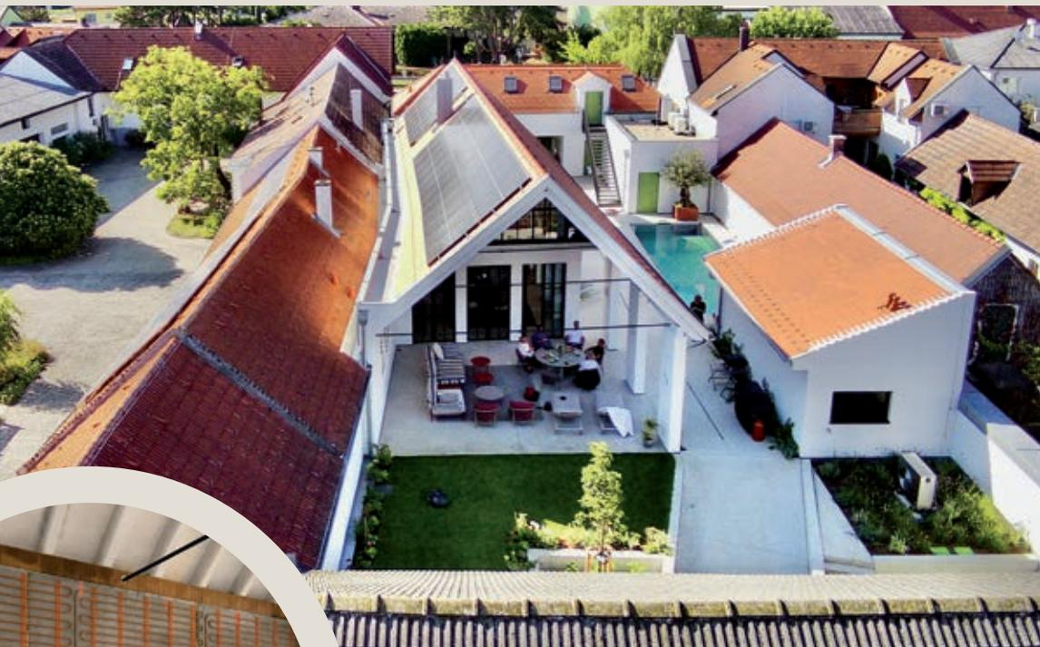
*Eine Photovoltaikanlage am Dach liefert 16 kWp Leistung. Die überdachte Terrasse wird das ganze Jahr genutzt. Über 70 m<sup>2</sup> Wandheizungen/-Kühlungen wurden aktiviert und wie in alter Römerzeit mit Kalkputz verputzt.*
