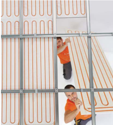
Die Deckenheizung im Trockenbau ist innerhalb weniger Tage montiert
