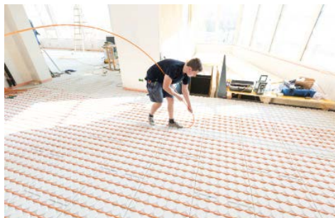
336 m 2 VarioKomp-Platten wurden als Trockenbau-Fußbodenheizung verbaut.
