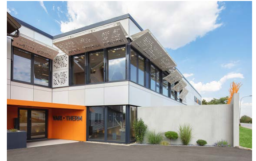
Auf 650 m 2 wurden Büroräume, ein Beratungs- und Schulungszentrum, ein Bereich für Forschung & Entwicklung und das VarioCafé gebaut.
