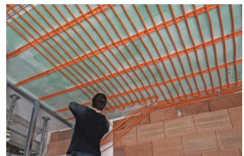
Bei der verputzten Decke werden die Halteschienen an der Decke montiert und das Heizungsrohr in den Schienen befestigt.
