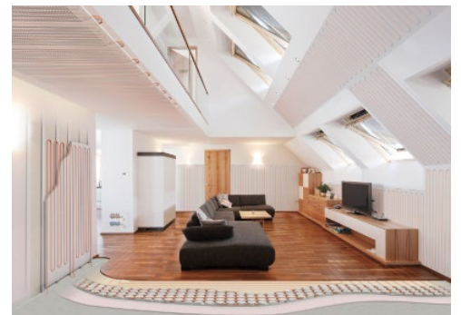
Wassergeführte Flächenheizungen arbeiten mit geringen Vorlauftemperaturen und heizen somit energiesparend und nachhaltig.
