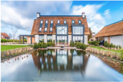
Eine Luft-Wasser-Wärmepumpe und eine Solaranlage sorgen für eine ressourcenschonende Energieversorgung.
