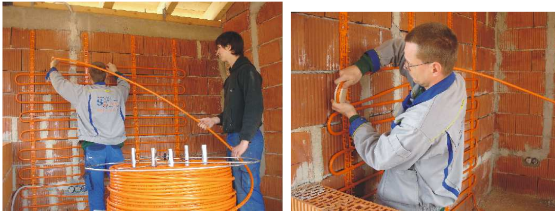
Bild „SWH2 verlegen“ und „rohr biegen.jpg“: Montage der System-Wandheizung mit dem VarioProFil-Rohr 16x2 / Alu 0,25
