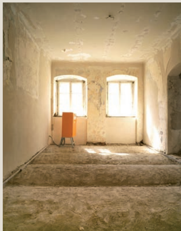
Die Böden in alten Häusern sind eine Herausforderung. In diesem Fall verbirgt sich unter der Oberfläche ein alter Gewölbekeller.
