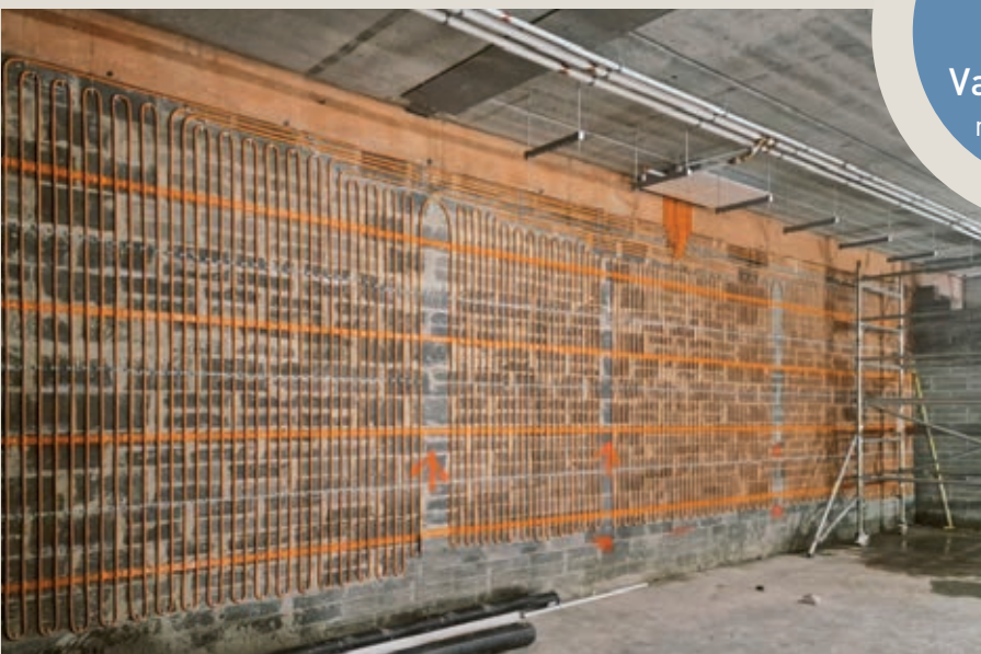
Die EasyFlexWandheizung/Kühlung ist höchst energieeffizient und lässig zu verarbeiten.
